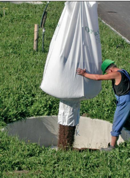
So schön kann Regenwassernutzung sein. Mit dem Mall-Terra-Regenspeicher wird die kombinierte Nutzung und Versickerung von Wasser nicht nur besonders einfach, sondern auch noch attraktiv, denn diese Anlage ist mit einer integrierten, belebten Bodenzone ausgestattet. In den meisten Fällen erfüllt das System die Kriterien der Erlaubnisfreiheit.
