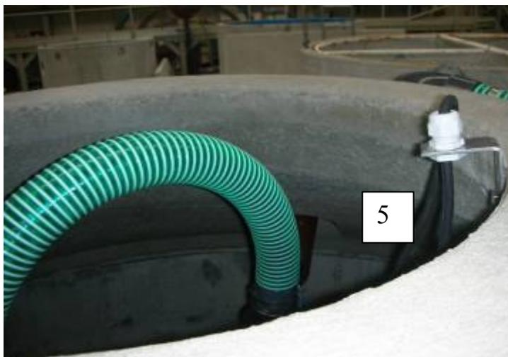
Druckspiralschlauch, Steuerkabel und Zuleitung der Pumpe (Elektrokabel) müssen nun mit zwei Kabelbindern an der Edelstahl-Haltestange (Pos. 2) befestigt werden.
