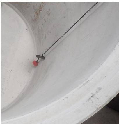
Bild 4: Einbau Schwimmer S2
