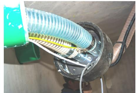
Bild 3 Schläuche anschließen
