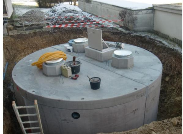
5. Die Abdeckplatten auf dem Behälterrand auflegen und verschrauben.
