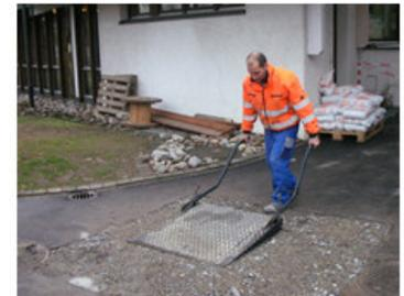
3. Pellet Maulwurf MW 6000 - E3 in die Befüllposition bringen. Wahlschalter der Anschlussbox auf „Befüllen“ stellen.
