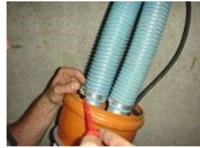
Bild 3 Schläuche anschließen
