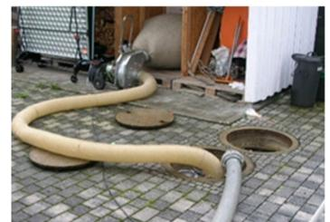
7. Während der Befüllung Fahrzeug und Schlauch erden
