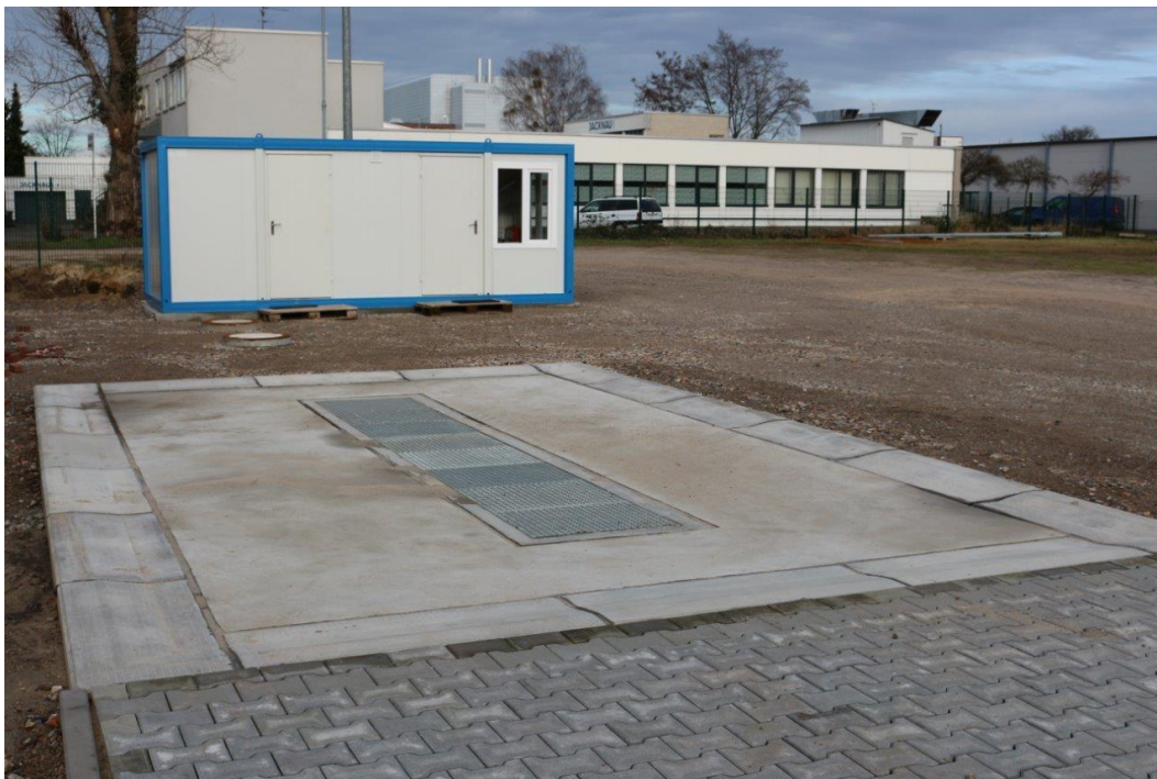
Bild 8 Beispiel Waschplatz mit NeutraCon 2200V Vorschlammfang und NeutraDens Absenkplatten
