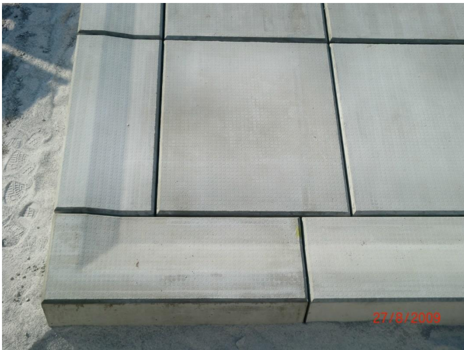
Bild 4 Detail NeutraDens Absenkplatte mit Eckelement
