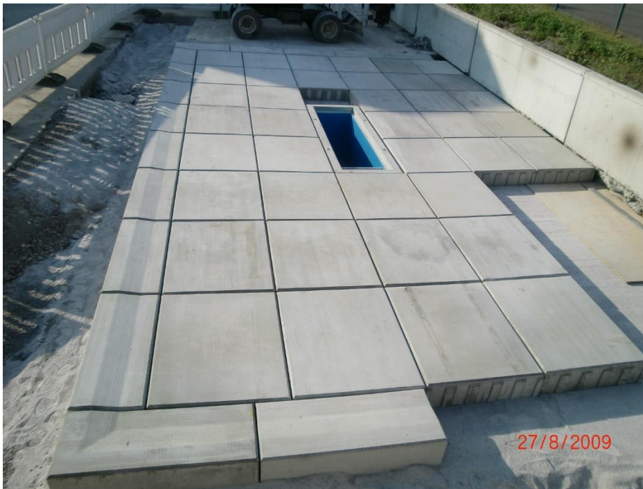
Bild 1 Tank und Waschfläche – Verlegung NeutraDens System
