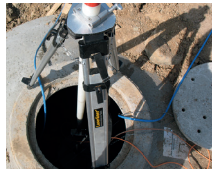
Prüfeinrichtung mit hydrostatischer Messsonde
