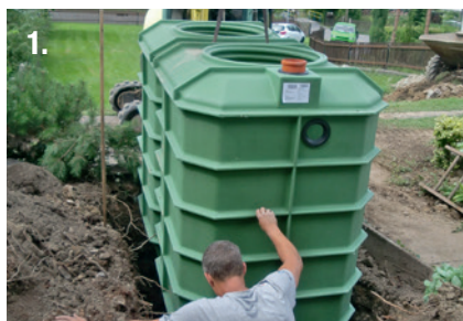
Versetzen PE Behälter
