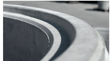
Bauteilverbinding mit Falz und bauseitiger Mörtelfuge
