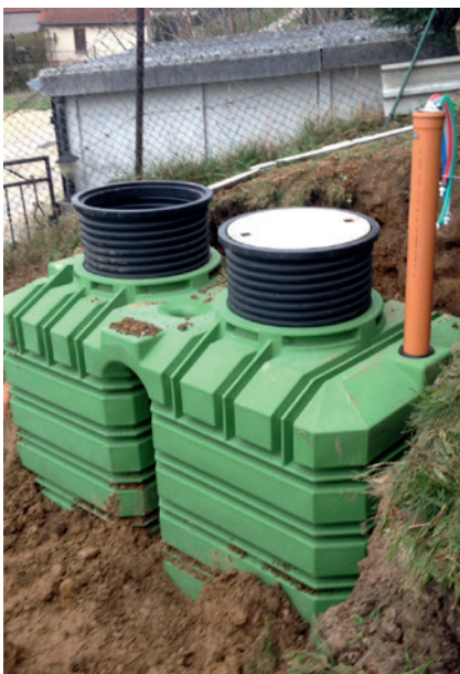
Kleinkläranlage SanoClean PE 6–8 EW
