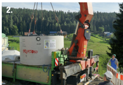
Anlieferung mit Mall-LKW
