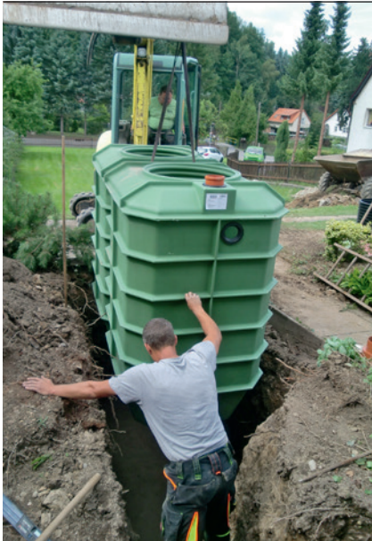
Kleinkläranlage SanoClean PE 4 EW
