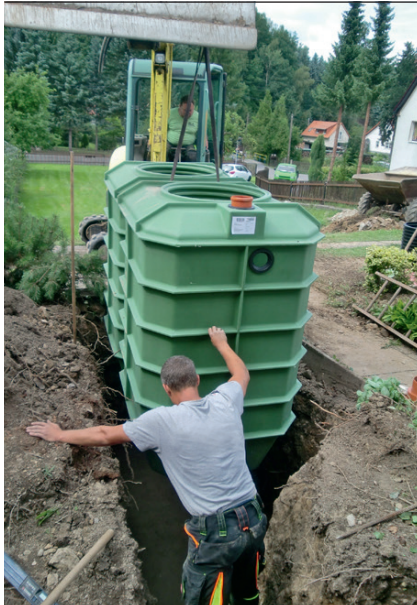
Kleinkläranlage SanoClean PE 4 EW
