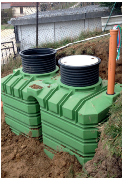
Kleinkläranlage SanoClean PE 6–8 EW
