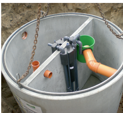
Ausrüstung Einbehälteranlage
