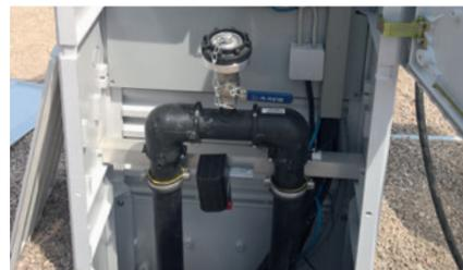
Foto: Mall | Rückstauschleife LevaStop
