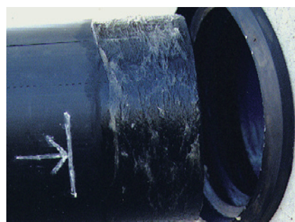
Bild 8: Herstellen der Rohranschlüsse
