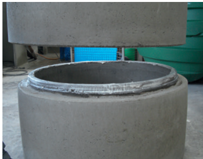
Bild 7: zentrisches Aufsetzen
