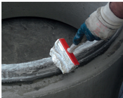
Bild 5: Auftragen des Gleitmittels
