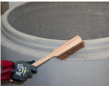
Bild 4: Reinigung der Verbindungsflächen
