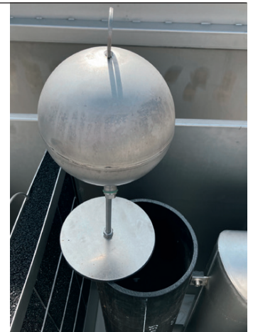
Bild 1: Schwimmer im Führungskorb
