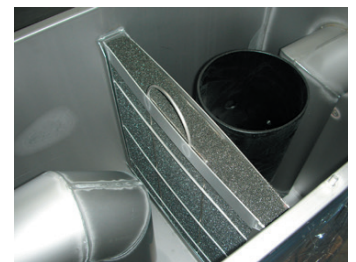
Bild 2: Koaleszenzeinsatz aus PU
