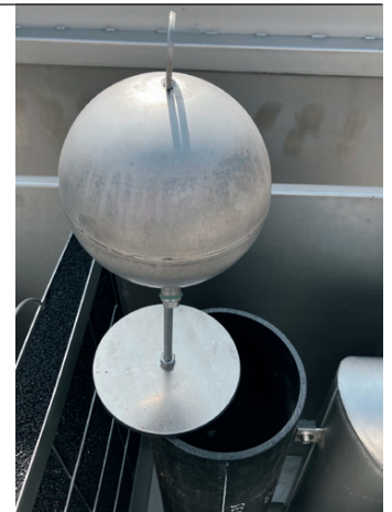
Bild 1: Schwimmer im Führungskorb
