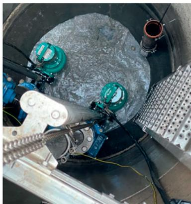
Die vormontierten Pumpstationen werden mit Mall-Kranfahrzeugen zur Einbaustelle gebracht und in die vorbereitete Baugrube versetzt. Direkt im Anschluss werden die Zu- und Ablaufleitungen angeschlossen, so dass noch am gleichen Tag mit den Verfüll- und Versiegelungsarbeiten begonnen werden kann.
