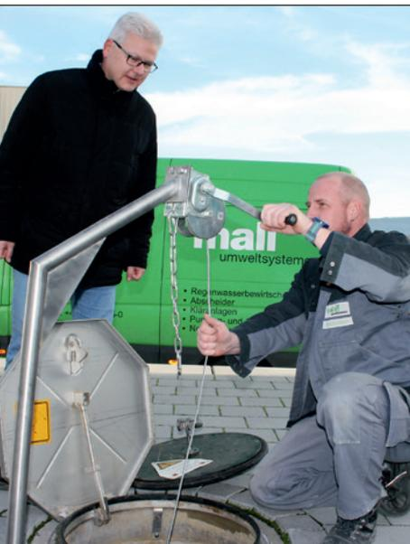
Die Wartung des Entnahmesystems soll durch eingewiesenes Personal bzw. im Rahmen eines Mall-Wartungsvertrags erfolgen. Sie besteht im Wesentlichen aus folgenden Bestandteilen und wird im jährlichen Intervall empfohlen:
