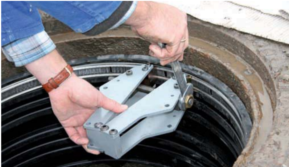
Einbau einer Dichtmanschette am Abscheider (linkes Bild). Ein typisches Schadensbild sind korrodierte Betonringe und ausgebrochene Fugen im Schacht.
