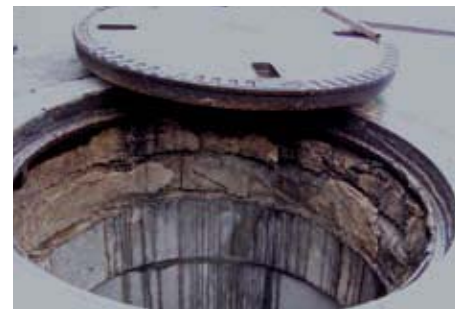
Einbau einer Dichtmanschette am Abscheider (linkes Bild). Ein typisches Schadensbild sind korrodierte Betonringe und ausgebrochene Fugen im Schacht.
