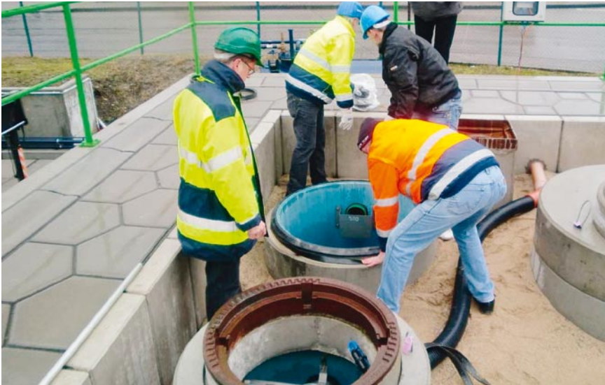
Im Praxisteil des Lehrgangs erhalten die Teilnehmer Anleitung bei Wartungs- und Kontrollarbeiten
